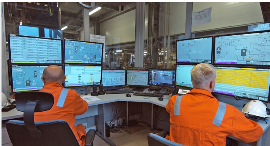
Centralna dyspozytornia zakładu Stepan Polska
