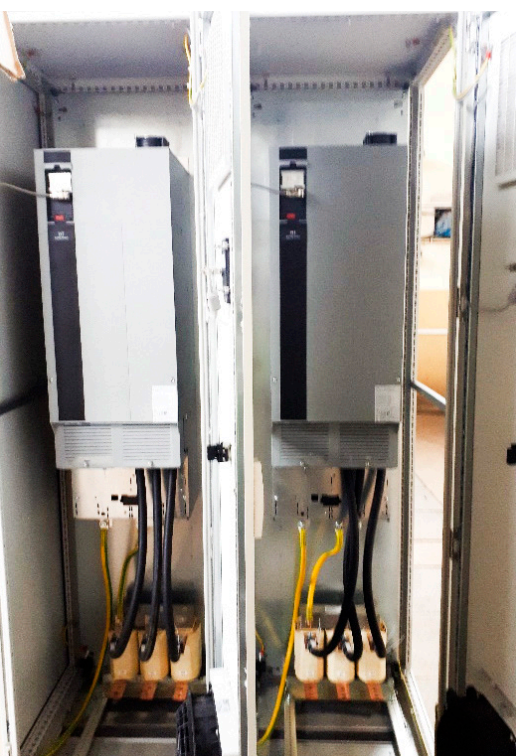
Jedna z dwóch szaf napędowych opartych na przetwornicach częstotliwości FC 202 AQUA Drive oraz filtry du/dt produkcji Danfoss
